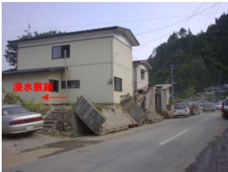
写真 4 JR 陸中松川駅付近の浸水家屋
