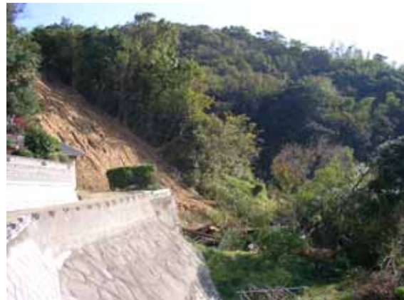
写真 4 兵庫県津名町里地区の斜面崩壊
