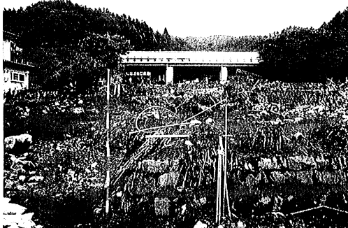
写真2 長野県岡谷市川岸東二丁目の土石流。中央付近に人的被害を生じた家屋があった。7月21日牛山撮影。
