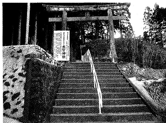
写真5 避難路の手すりが塗り替えられた現場
