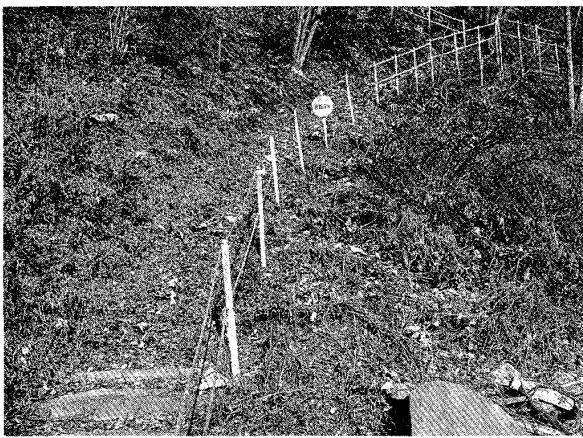
写真6 避難路入り口の草刈りが行われたと見られる現場 この歩道は避難場所で行き止まりとなっており、避難場所への通路として以外の機能は持っていない。
