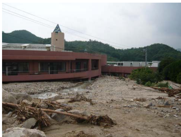
写真1 2009年7月21日の豪雨によって発生した土石流に見舞われた山口県防府市真尾地区の建物。付近は土砂災害警戒区域に指定されていた。土砂災害の素因がある場所に豪雨という誘因が作用して災害がもたらされた。
