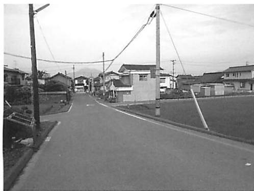
写真5 災害前の気仙小学校校庭から東方を見る。気仙川の堤防や海は見えない。2008年7月18日牛山撮影。
