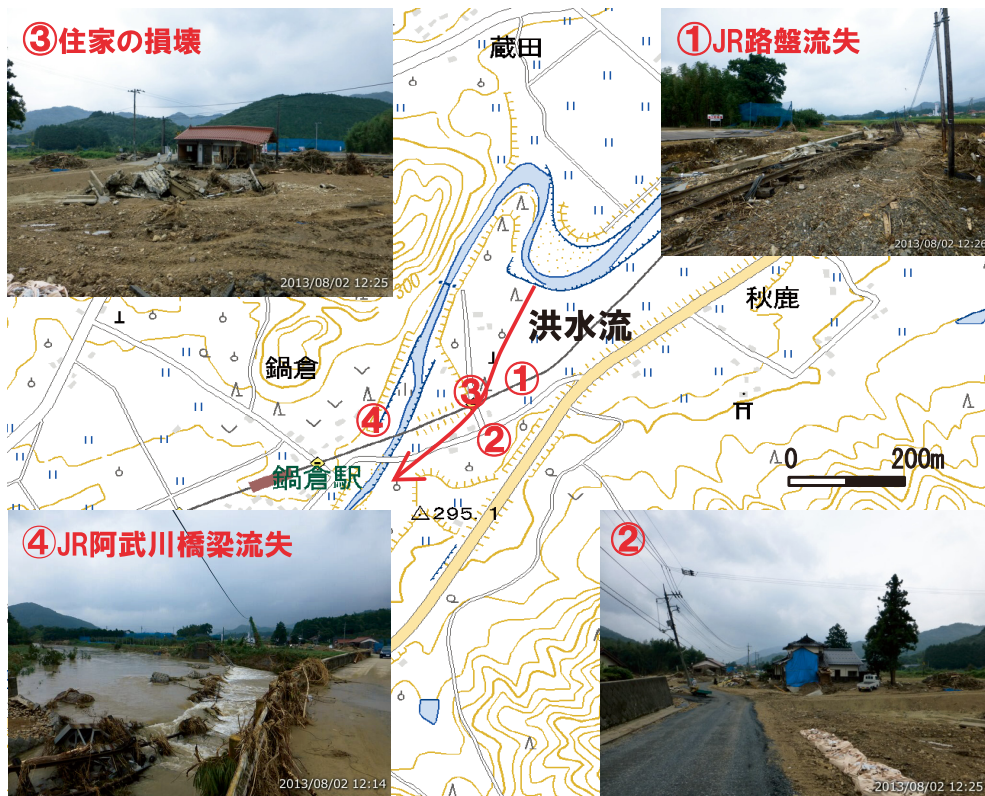
図6 山口市阿東鍋倉付近の洪水による被害状況（背景図は電子国土より）
