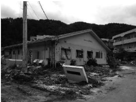
写真-3 死者9人が生じた岩泉町乙茂のグループホーム
